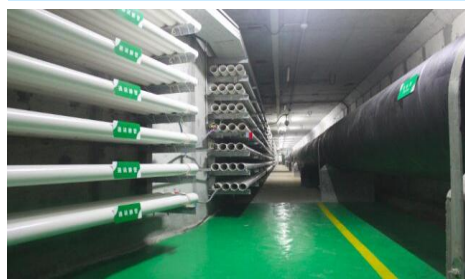
珠海横琴地下综合管廊
