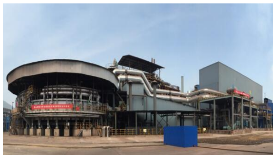
转底炉固废处理
