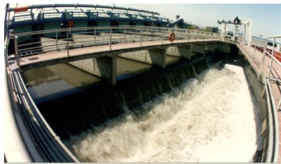
上海合流污水治理一期工程
