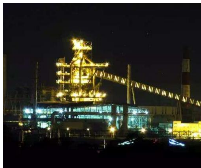
河静钢厂高炉炉顶
