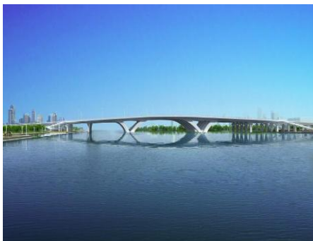
于新道跨海河大桥
