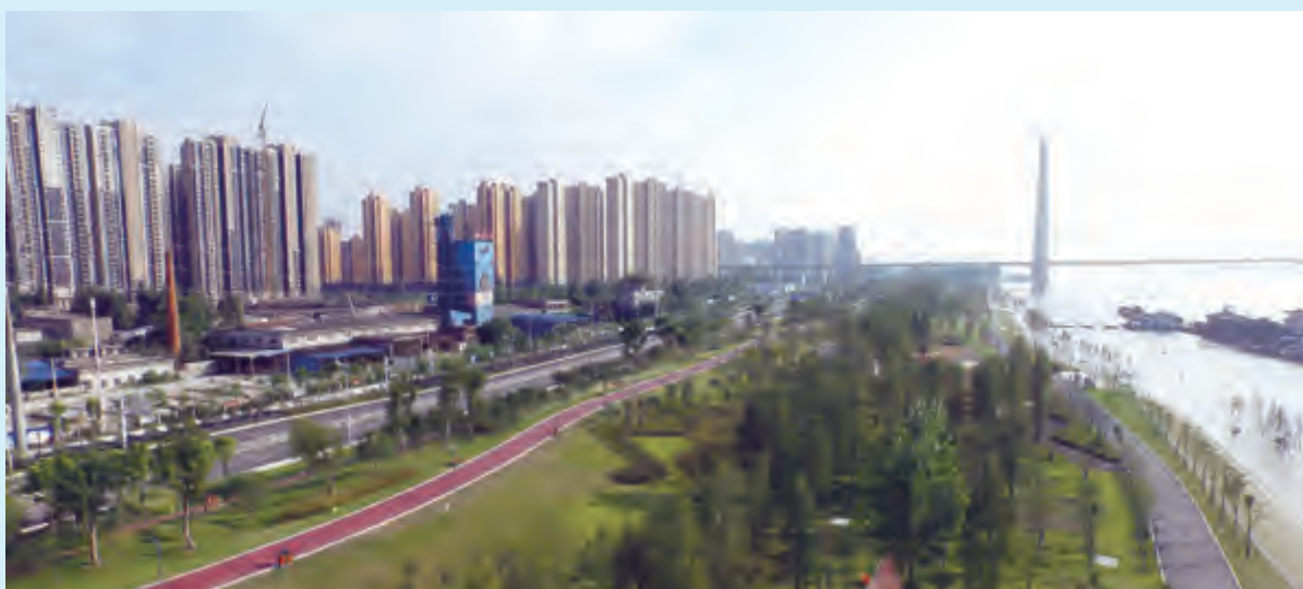
武汉市武青堤江滩综合改造工程
