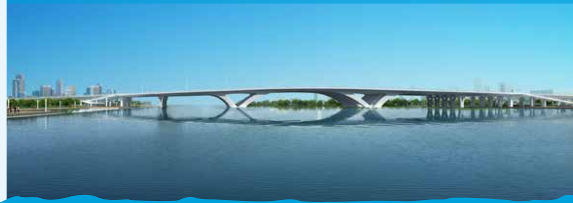
于新道跨海河大桥
