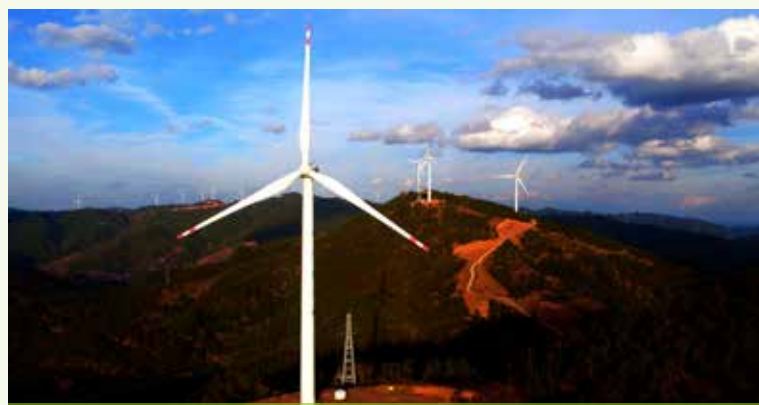
四川凉山州风电场项目
