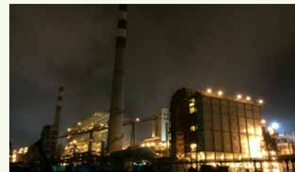
正在运行中的脱硫脱硝装置
