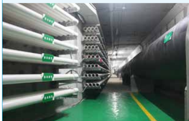
珠海横琴地下综合管廊
